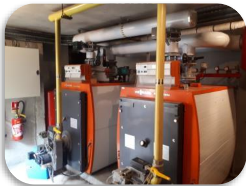
Vue chaufferie avant travaux
